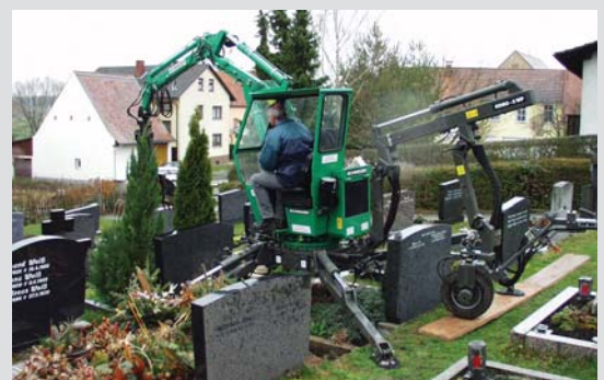
Abstützen und Baggern
