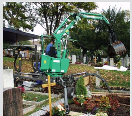
Abstützen und Arbeiten
